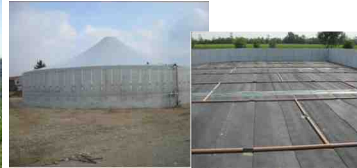
Copertura degli stoccaggi
